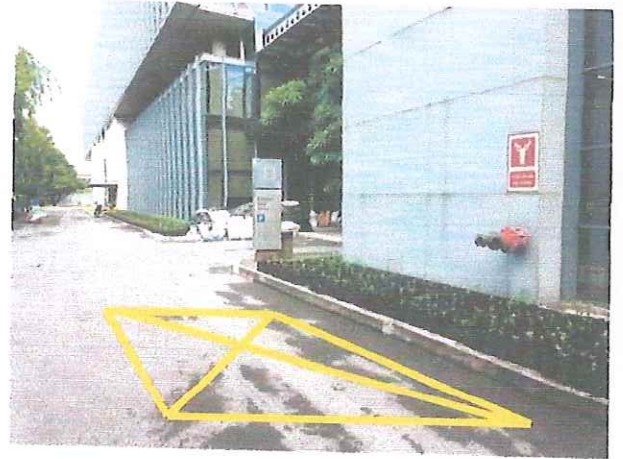
จุดที่ 2 บริเวณหลังอาคาร B
